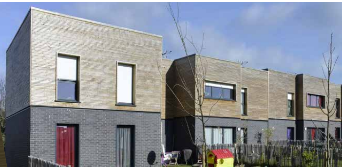
Bardage Sapin du Nord, profil Faux Claire Voie XXL, préservé vert - Le Havre (76) - Architecte : CBA
