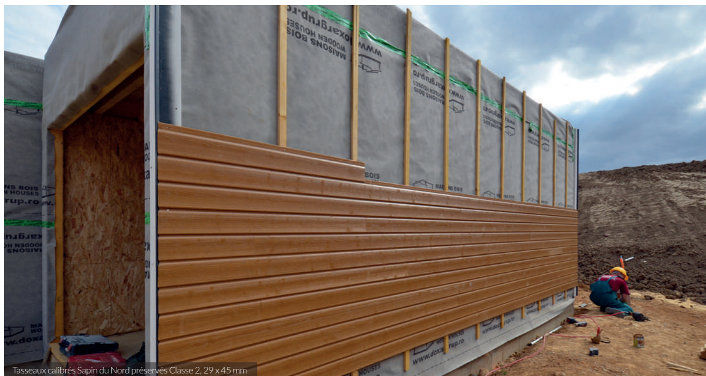
Tasseaux calibrés Sapin du Nord préservés Classe 2, 29 x 45 mm
