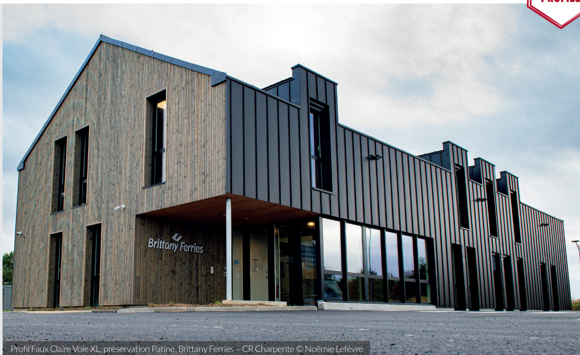
Profil Faux Claire Voie XL, préservation Patine, Brittany Ferries – CR Charpente © Noémie Lefèvre
