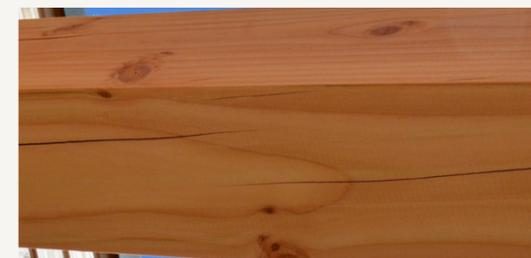
Le bois est sujet à des variations dimensionnelles en fonction du taux d'humidité et de la température. Lorsqu'il sèche, il se rétracte de façon irrégulière, entraînant l'apparition de fentes.
