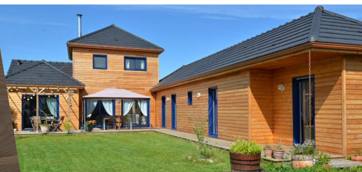
Bardage Mélèze Naturel profil Oural - Maison individuelle (28) - Constructeur : Le Drein Courgeon
