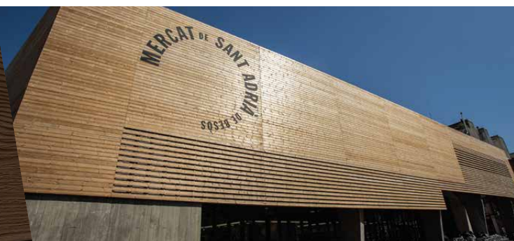
Bardage Thermowood Profil Élégie Biaise - Centre commercial Barcelone - Architectes : Maria Manrique et Gisela Planas
